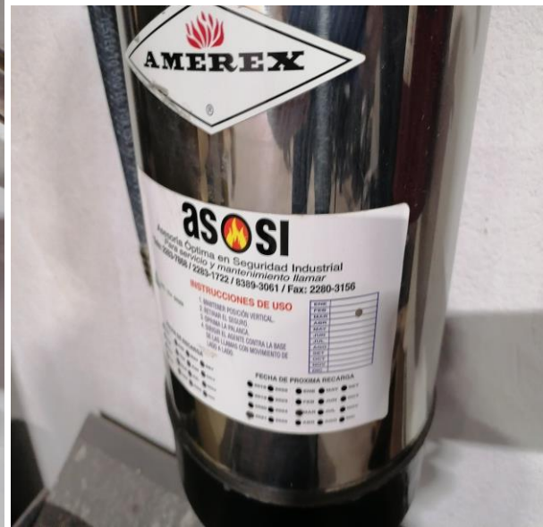
Fotografías N°3, 4, 5 y 6: Extintores en la entrada a la bodega que expiraron en marzo del 2020, según consta en la etiqueta del extintor.
