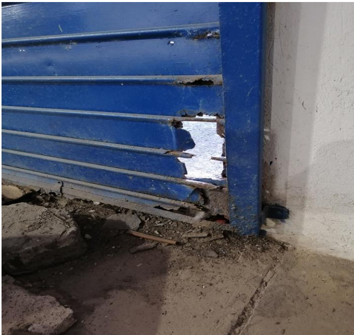
Fotografía N°7: Portón en la bodega donde se custodian los expedientes inactivos.
