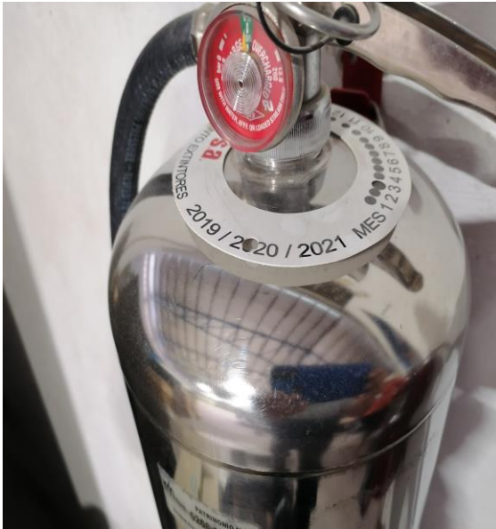
Fotografías N°3, 4, 5 y 6: Extintores en la entrada a la bodega que expiraron en marzo del 2020, según consta en la etiqueta del extintor.
