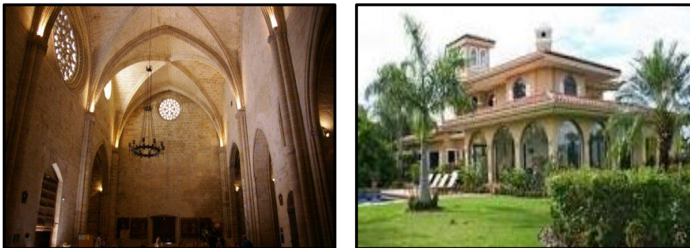
Ilustración 2 Sistema Constructivo Abovado
