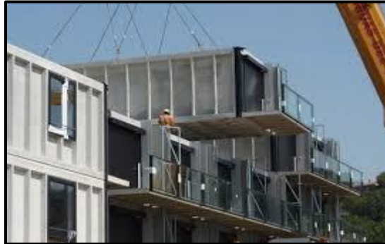
Ilustración 9 Sistema Constructivo de Células Tridimensionales
