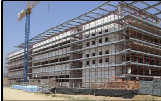
Ilustración 7 Sistema Constructivo de Paneles Estructurales
