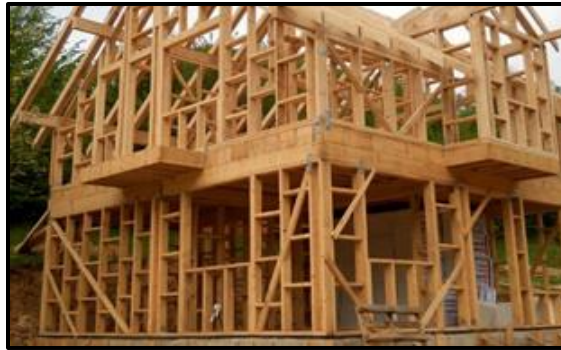
Ilustración 5 Sistema Constructivo Marco de Madera
